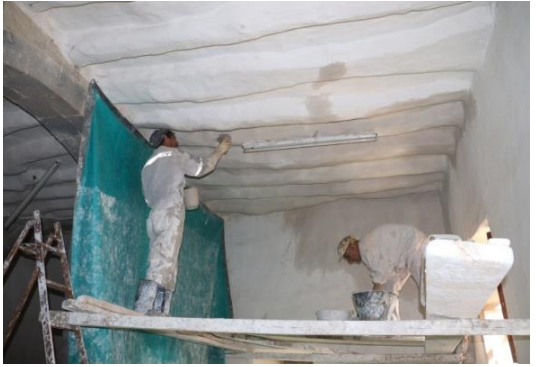
توريد طرايل لتغطية الجدران الحباش والارضيات حتى لا تتأثر من مادة الجص
