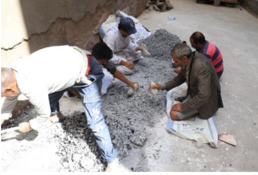
تحضير النورة وعمل الأحواض الخاصة بالتخمير للقضاض ( دق وخلط وتخمير )
