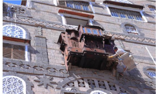
ترميم المشربيات الكبيرة وتنظيفها ودهنها بالزيت
