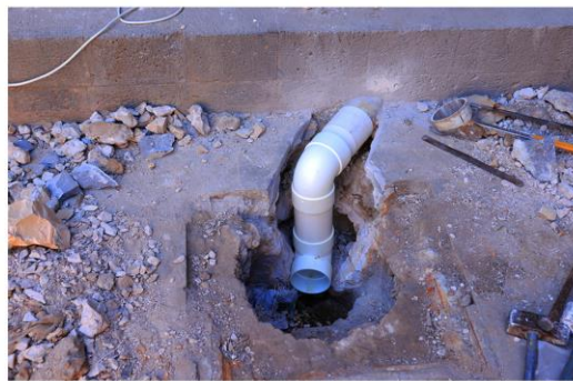
تفقد مواسير الصرف الصحي التالفة للحمامات الداخلية وتنظيف غرفة التفتيش (المجاري)
