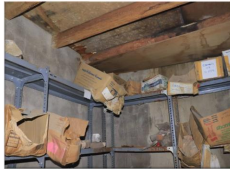
مخزن أعمال البعثة الألمانية - تسرب مياه الامطار وتضرر القطع
