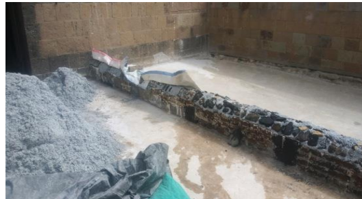
إقامة جدار من الحجر والياجور بارتفاع ٤٠ سم وعرض ٤٠ سم في الشرفة الشمالية بعد تكسير السطح لغرض تثبيته، تم استخدام مادة القضاض والجص كمادة للربط
