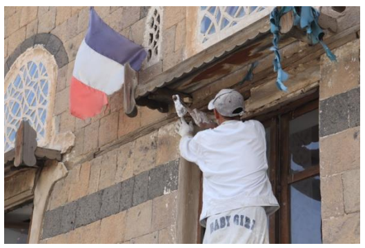
تفقد الكنن وإصلاحها وتركيب كنن جديده بدل التالفة بنفس نمط ونوع خشب الكنن السابقة
