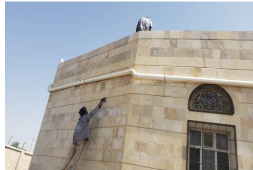
تنفيذ اعمال الجليخ للواجهات الحجر لمبنى المتحف قبل تنفيذ العازل
