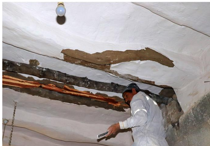
إصلاح خشبة سقف الدور الأول التي اتضح انها مكسورة عند إجراء أعمال الكشط
